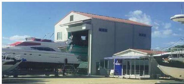
＜フィッシャリーナ天草内サービス工場＞
