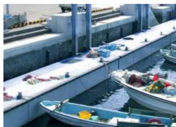
＜FRP 浮棧橋（ポンツーン）＞
