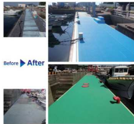
＜施工（補修）前後＞
